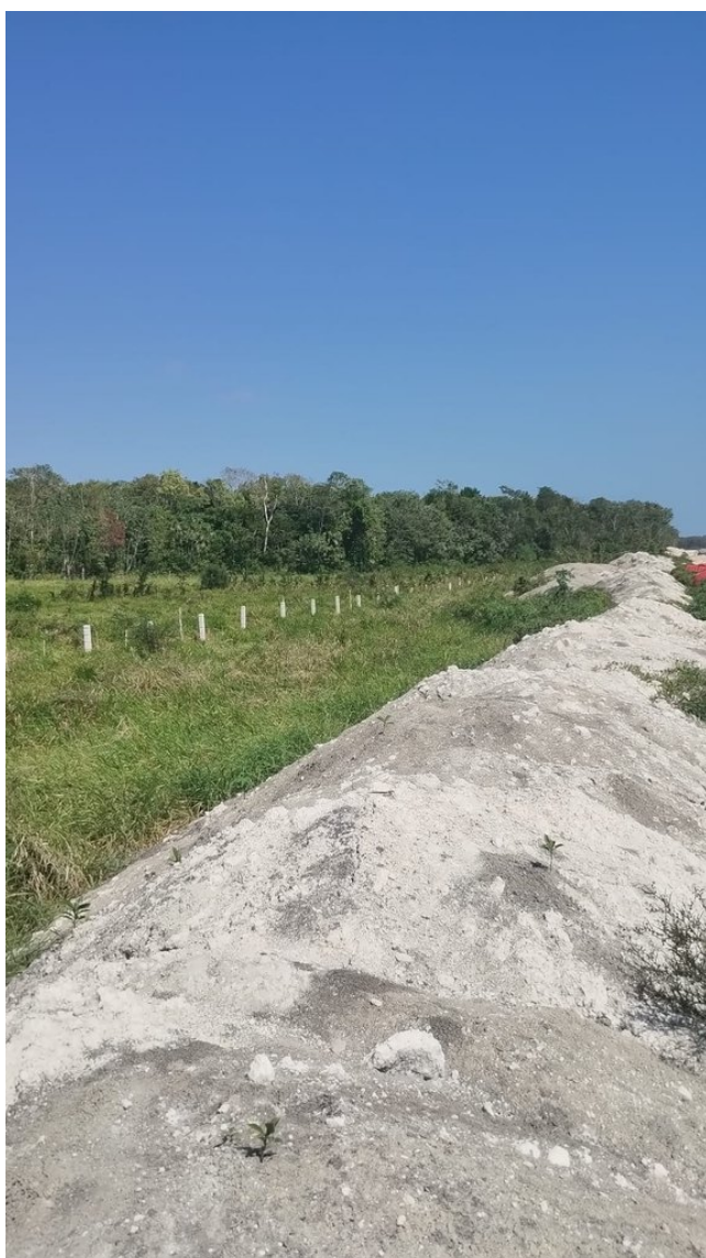
Confinamiento del derecho de vía.
