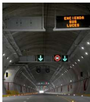
Acatúnel · Entronque Brisamar
