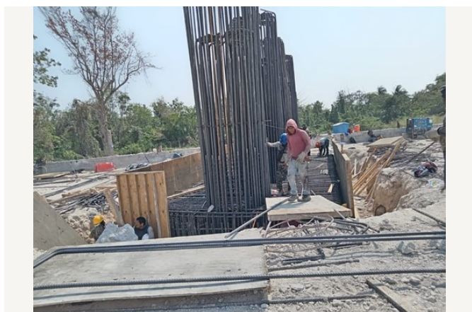
Cimbrado de elementos de cimentación.
