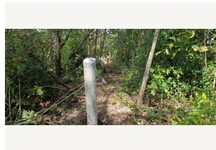
Poste para delimitación del DDV.
